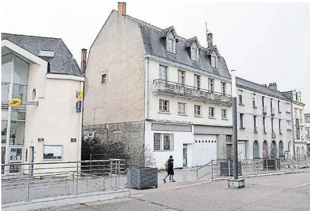
Entre le Marin'hôtel et La Poste, l'îlot Garot, comprenant l'ancienne trésorerie, accueillera le nouveau centre d'affaires, porté par Actual. L'hôtel, lui, devrait s'agrandir.
